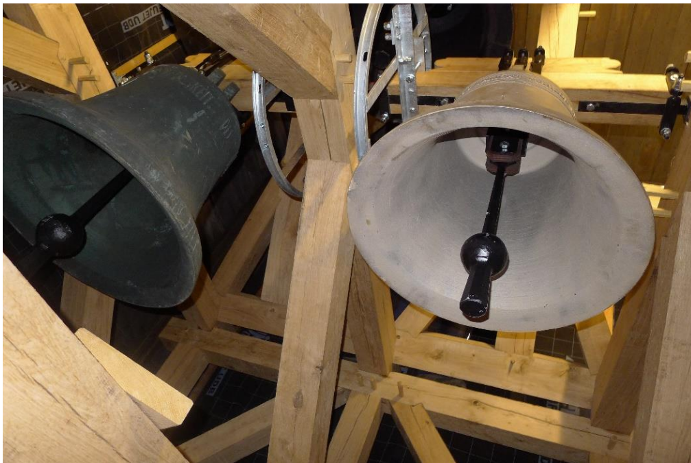
Abb. 4: Einbau neuer Glockenstuhl mit renovierten Glocken in 2020
